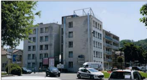
réseau ventilation double flux en façade
