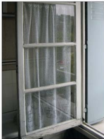
menuiserie existante simple vitrage
