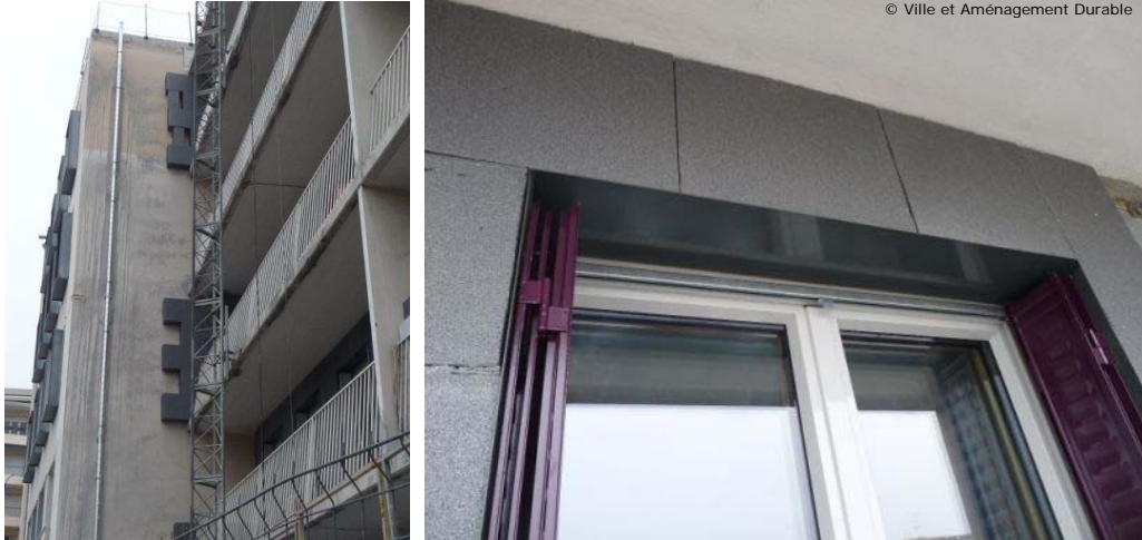
Mise en oeuvre de l'isolation par l'extérieur
