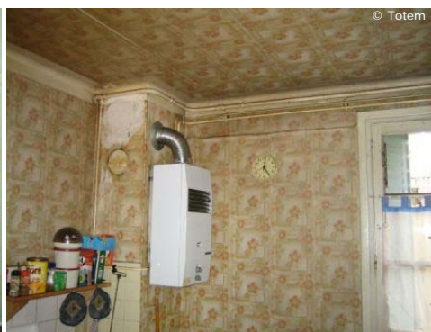
Dans chaque logement : poêle à gaz dans le couloir et chauffe-eau gaz dans la cuisine.
