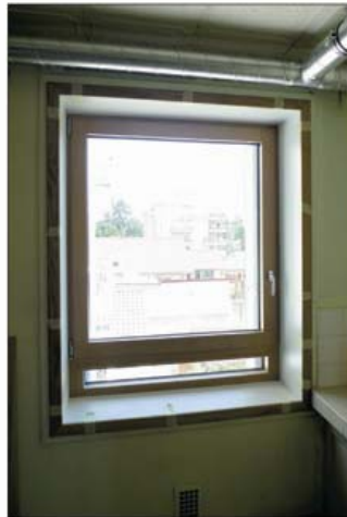
nouvelle menuiserie triple vitrage bois/alu + précadre de finition intérieure
