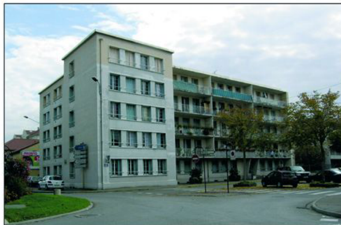
Ensemble immobilier Maréchal Leclerc avant réhabilitation
