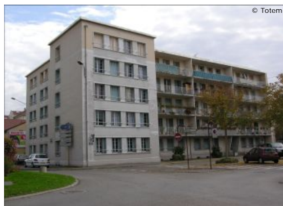
Façades Sud et Est
