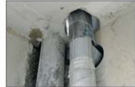
passage de ventilation en façade
