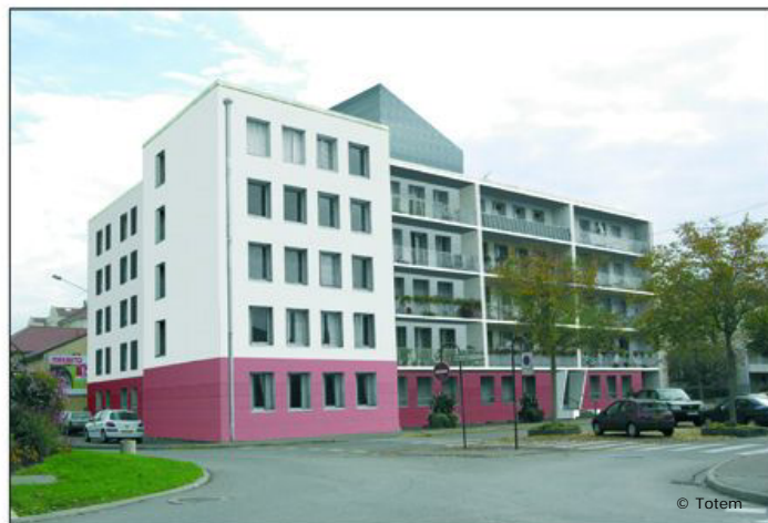
Ensemble immobilier après réhabilitation (VUE ARCHITECTE)
