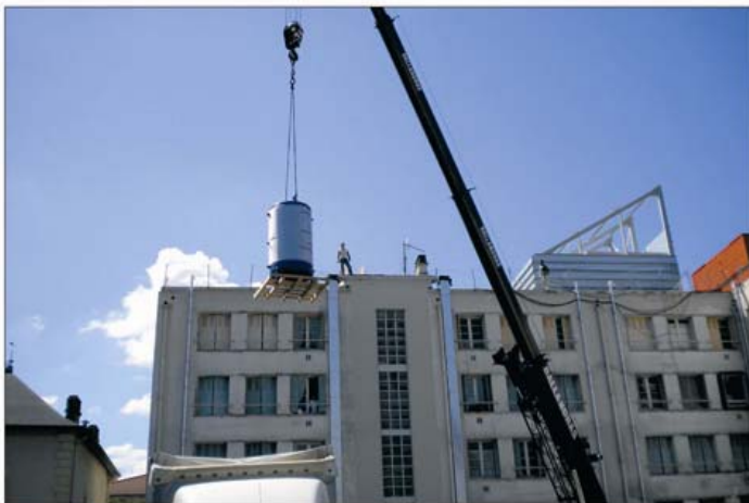
grutage du ballon de stockage dans le local technique en toiture
