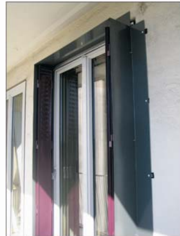
nouvelle menuiserie triple vitrage bois/alu + précadre extérieur + persienne métal
